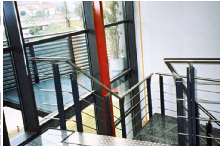
Treppenaufgang mit Edelstahlgeländer, Metallintarsien. Gut gelungen, der angebaute Balkon mit Stahlträgern und Wellblechverkleidung.
